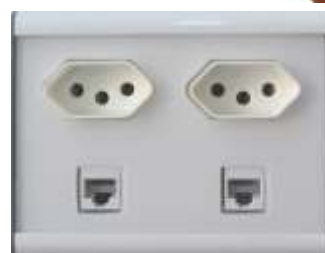
Duas tomadas de alimentação 110/220 Volts 20 A e duas tomadas de dados RJ.
