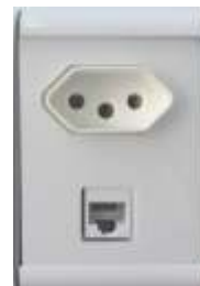
Uma tomada de alimentação 110/220 Volts 20 A e uma tomada de dados RJ.
